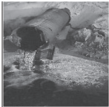
تصویر شماره ۲-۶: آلودگی ناشی از پساب فعالیت‌های کارگاهی و صنعتی
