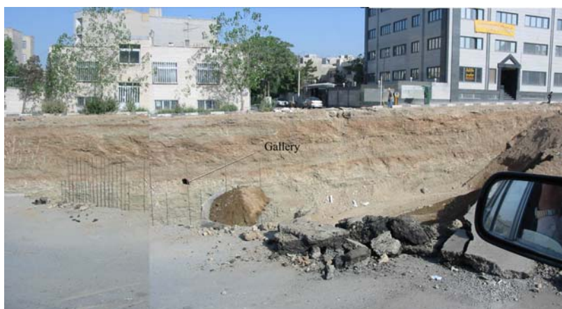
شکل شماره ۲۳-۲- قطع گالری کاریز به علت احداث زیر گذر شمالی - جنوبی میدان نور صادقیه (تاریخ ۱۳۸۴/۴/۲۰)
