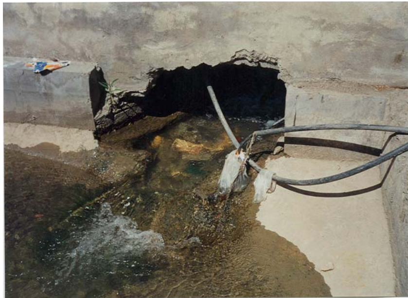
شکل شماره ۱۶-۳- مظهر کاریز عباس آباد در مصلی تهران که آب خروجی در جوی خیابان جاری می شود و به مصرف آبیاری در ختان حاشیه خیابان می رسد. (به نقل از آرشیو شرکت پردازش شهرداری شهرداری تهران)
