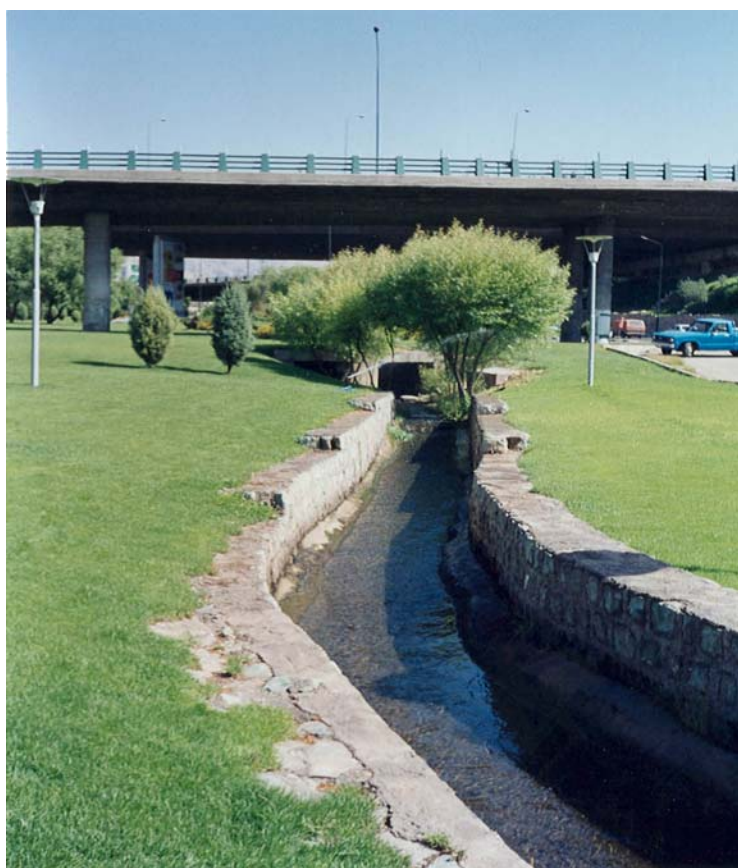
شکل شماره ۱۵-۳- مظهر و هرنج کاریز عباس آباد در رفیوژ بزرگراه مدرس (به نقل از آرشیو شرکت پردازش شهرداری شهرداری تهران)
